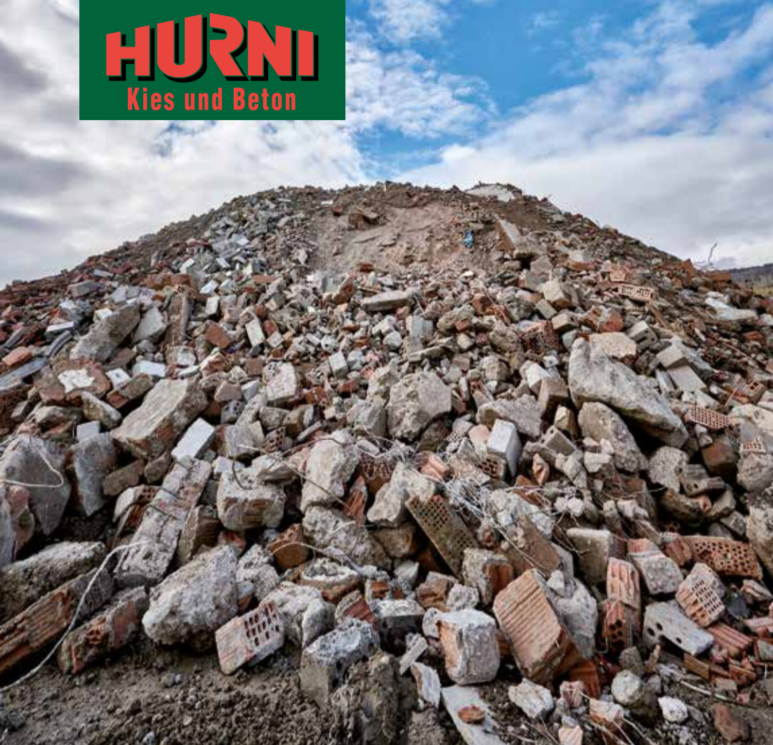
Stockage intermédiaire pour les gravats non triés
