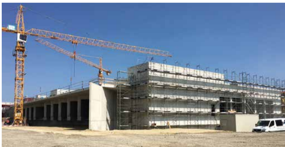
Centre de logistique de Marti Kallnach S.A.: 10'000 m 3 de béton et seulement 5 mm de tolérance.
