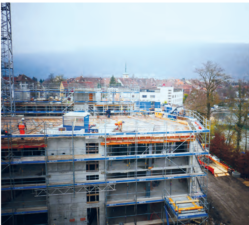
Quatre immeubles multifamiliaux sont construits près de la Thielle à Nidau.
