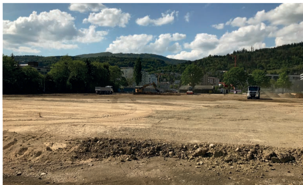
L'entreprise Hurni livre du matériau de remblaiement pour l'aménagement du terrain.
