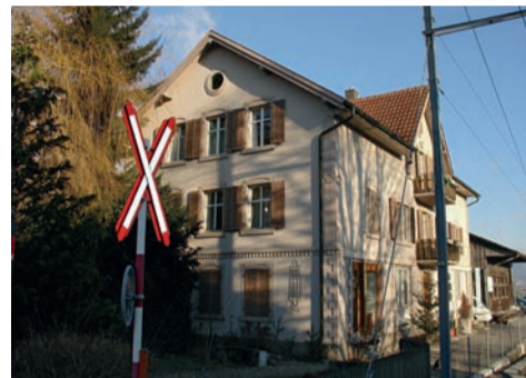
L'ancienne menuiserie avant la rénovation.
