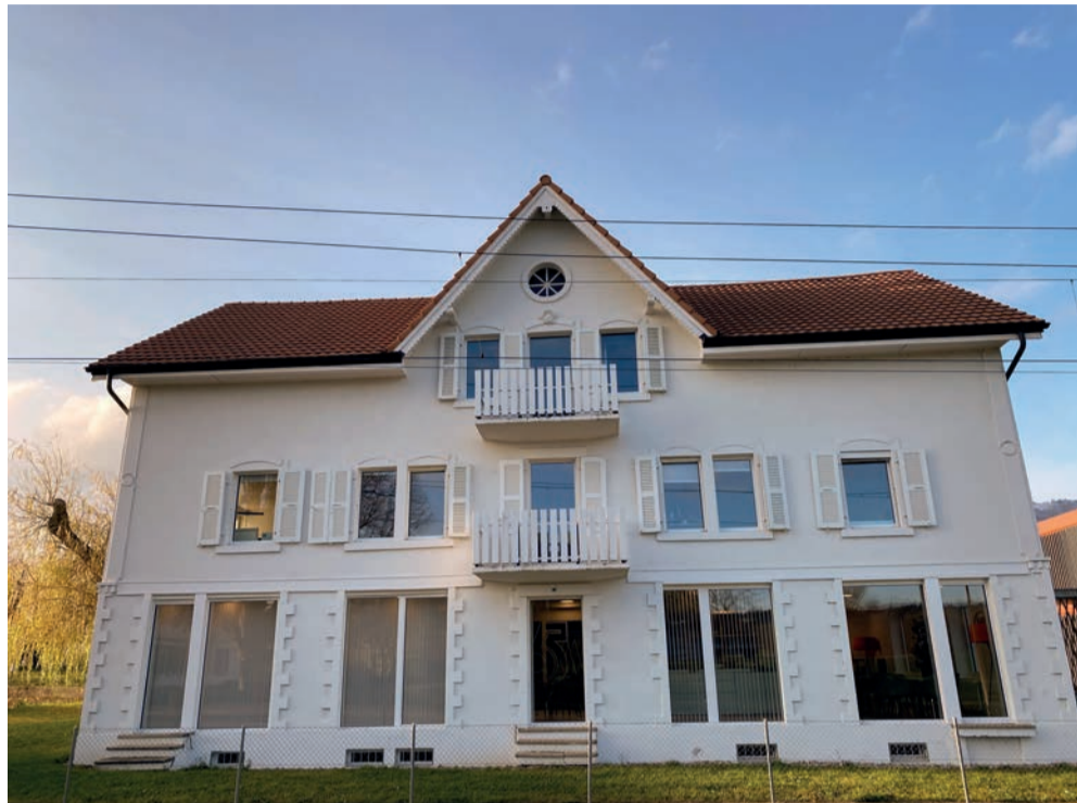
Le bâtiment administratif de l'entreprise Hurni respire à nouveau.
