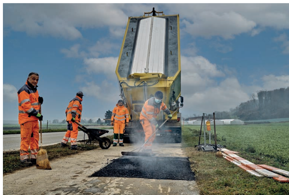
Thermo-benne à deux compartiments en service.
