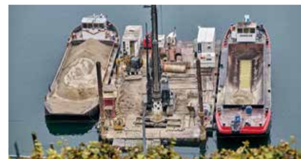
Travaux préparatoires pour le 2 e tracé ferroviaire CFF
