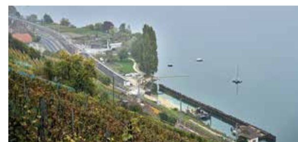
La 2 e voie exige plus de place
