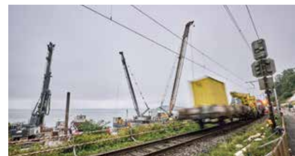
Tracé ferroviaire CFF fortement fréquenté
